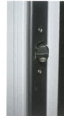
Grâce à une sécurité électrique discrète, en standard, le mouvement motorisé de la porte est impossible si le portillon n'est pas fermé. La serrure 5 points\* à pènes semi-circulaires et gâches en acier garantit une protection contre toute tentative d'effraction. Le système anti pince-doigt vous assure une fermeture de la porte sans danger.
