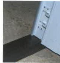
Une faible hauteur de seuil de 25 mm et une largeur de 800 mm permettent un passage aisé.
